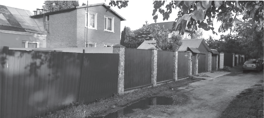
Рисунок 4 – Фотофиксация существующего состояния территории
